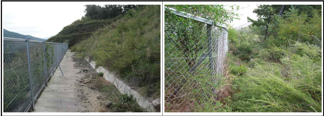
【그림 2.3.3】 배수시설 전경
